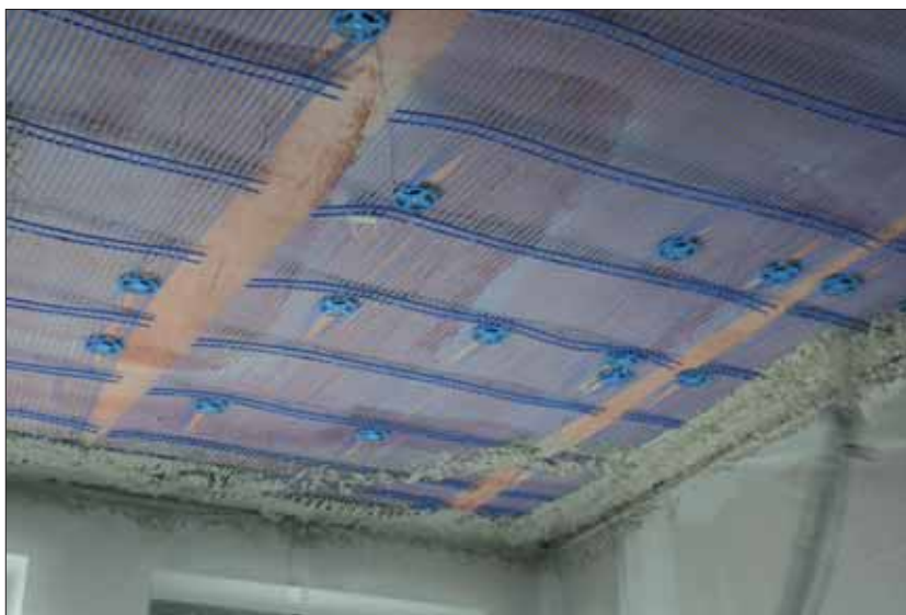
Bild 3. Kapillarrohrrmatte als Flächenkühlung
